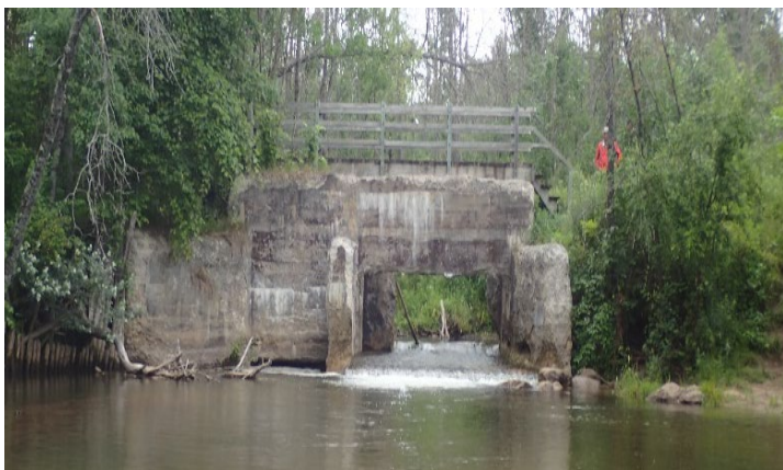
Avant l'enlèvement du barrage de Buhl. Source : A. Ania
